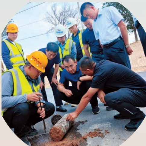
▲ 7月3日，驻交通运输部纪检监察组在红寺堡区红恩路项目工地现场督导，查看工程基本施工情况，推动加快工程进度、保证工程质量。
